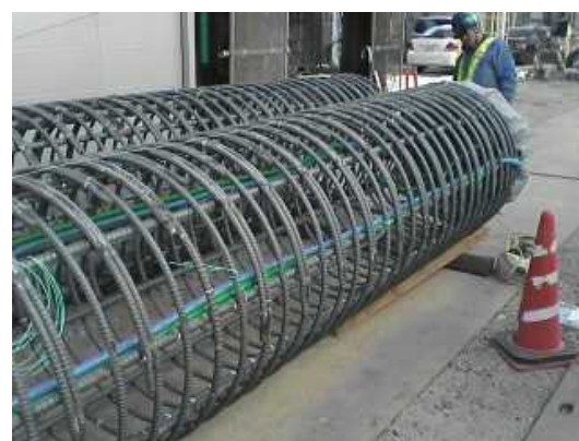
写真 16 ホース類を鉄筋かご内側に通した例
