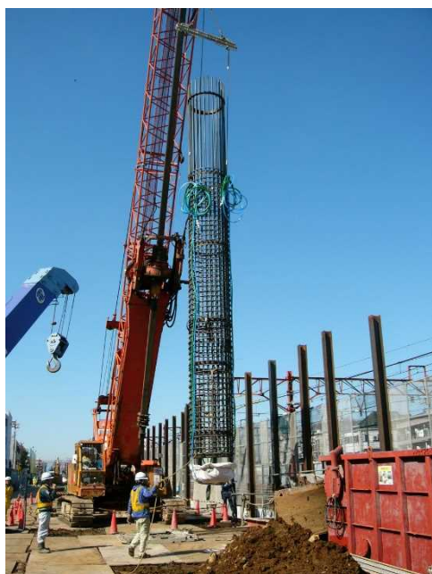
写真 18 鉄筋かごの建込み状況
