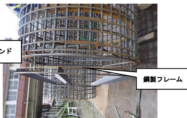
写真2 鋼製フレーム
