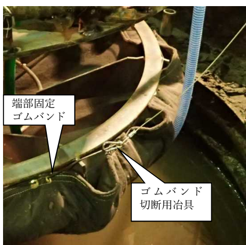
写真 20 ゴムバンド切断用治具設置状況
