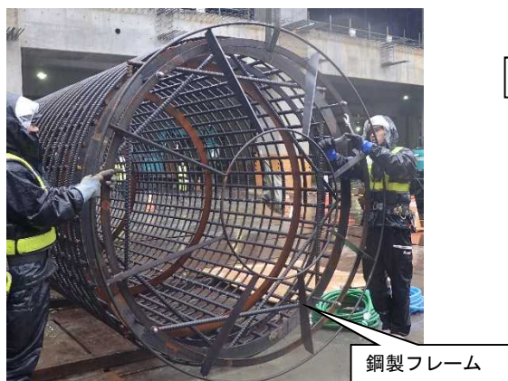
写真8 鋼製フレーム
